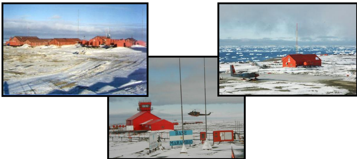
Figura N° 2: Instalaciones de la BAP Marambio.
