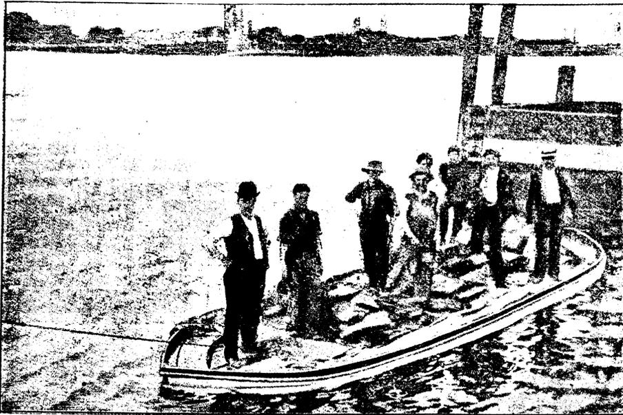
*Fig. 3* BOTE ENGELHARDT CON 8 HOMBRES Y 400 KILOS DE LASTRE
