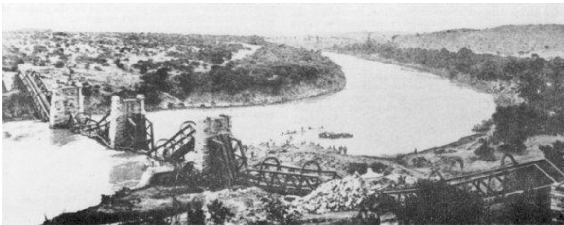
El puente del ferrocarril en Colenso; destruido, el puente carretero estaba al fondo de la curva del río.
