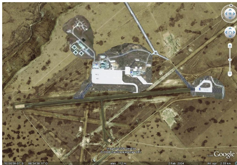
Fig. 83. Vista esquemática de la BASC, con sus instalaciones construidas.
