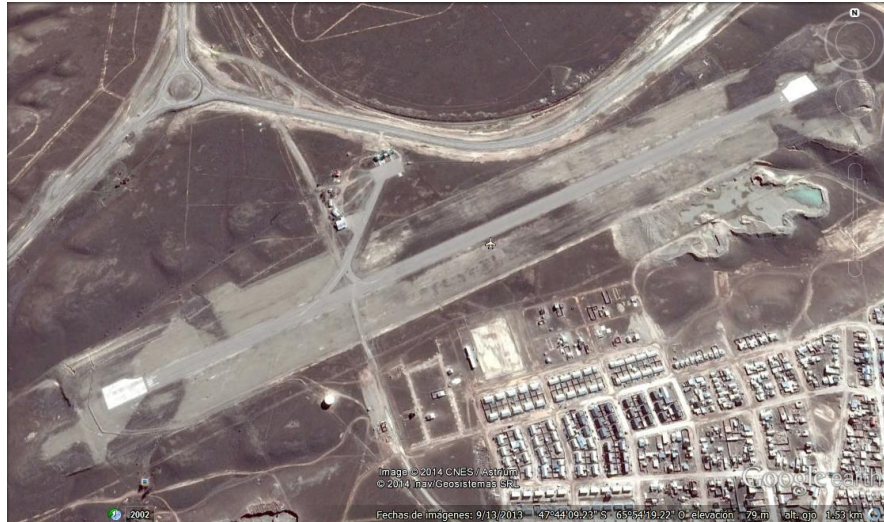
Fig. 82. Vista esquemática de la BAPD, con sus instalaciones construidas.
