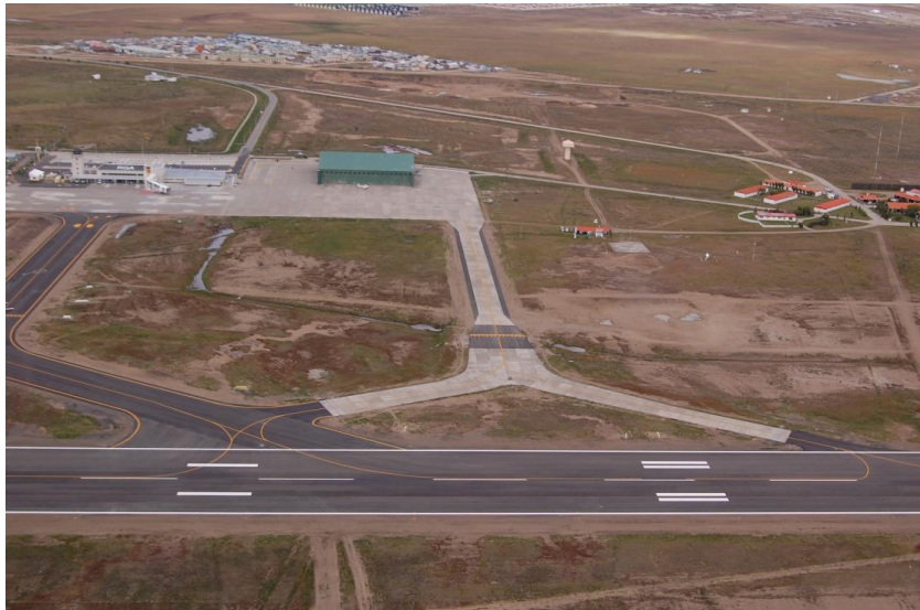
Fig. 84. Vista aérea parcial de la BARD, con sus instalaciones actuales.
