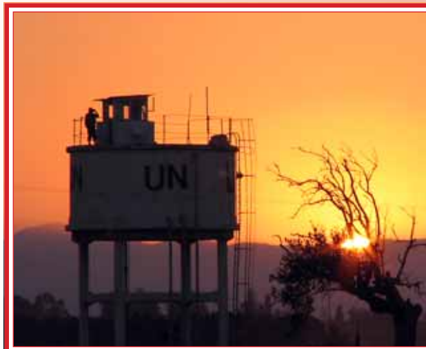
(Puesto de Observación de UN N° 38 ubicado frente a la Villa de Avlona donde personal de la EP 03 realiza observación permanente)
