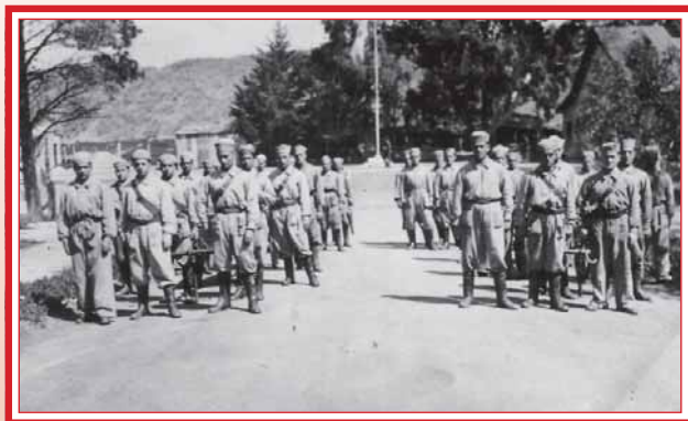
Baterías 1939-1948, Primera ESIM edificios en segundo plano
