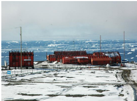
Zona del helipuerto y hangares para DCH-6 Twin Otter y Bell 212 de la FAA en la Base Antártica Marambio
