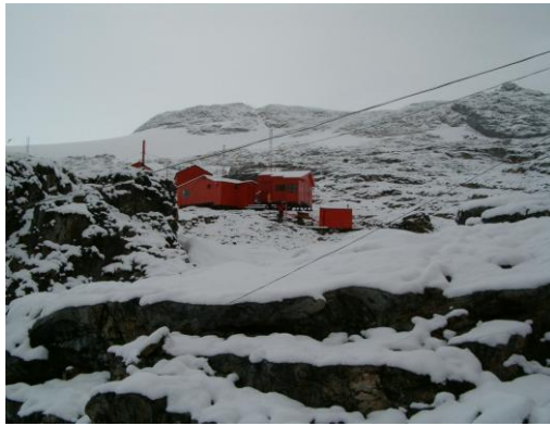
Vistas panorámicas de la Base Antártica San Martín
