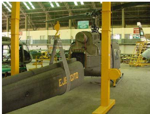
Foto 1 – Descalzado del cono de cola
