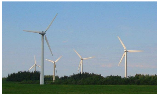
Fig. II. Campo eólico en Hamburgo, Alemania.
