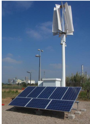
Fig 13. Sistema Híbrido solar - eólico
