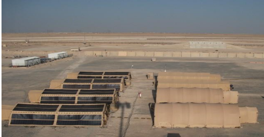
Fig 20. Paneles solares instalados en la parte superior de tiendas de campaña. USAF
