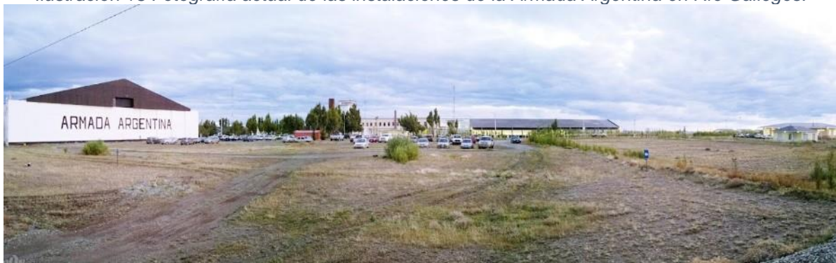
Ilustración 13 Fotografía actual de las instalaciones de la Armada Argentina en Río Gallegos.
