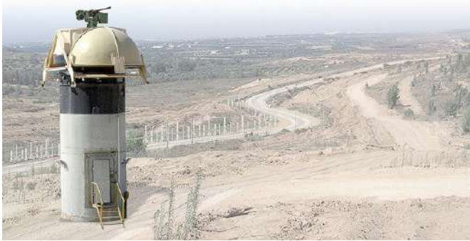
FIGURA 29: SENTRY TECH EN SISTEMA DE VIGILANCIA FRONTERIZO. (ISRAEL). SISTEMA DE TORRES DE VIGILANCIA “SABRAS” CON ARMAS AUTOMÁTICAS OPERADAS REMOTAMENTE
