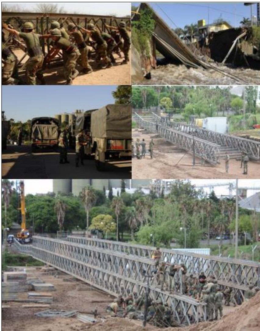
Figura 8. Construcción de puente Mabey DD reforzado en San Lorenzo, Santa Fe.
