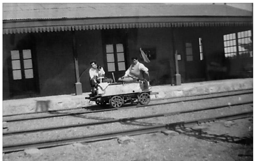
Una zorra de vía y obras a motor en Tellier en 1940.
