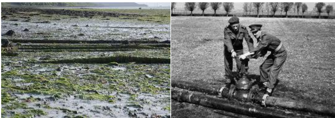
Exclusa de la cañería en la Isla y vista de las cañerías con la marea baja (British Army Collection, National Archives UK)
